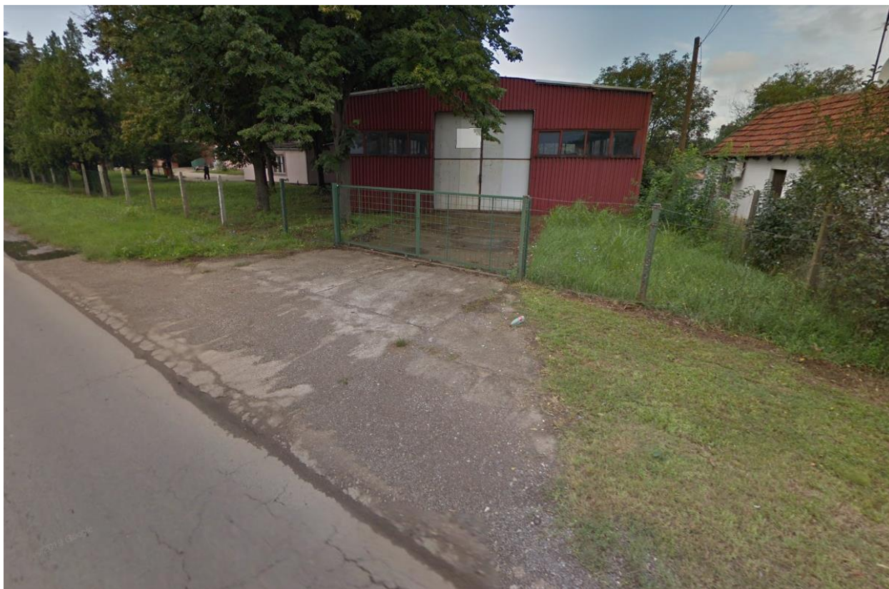
Slika 8. Postojeće skladište koje je potrebno srušiti (demontirati) i stambeni objekat najbliži zoni radova
