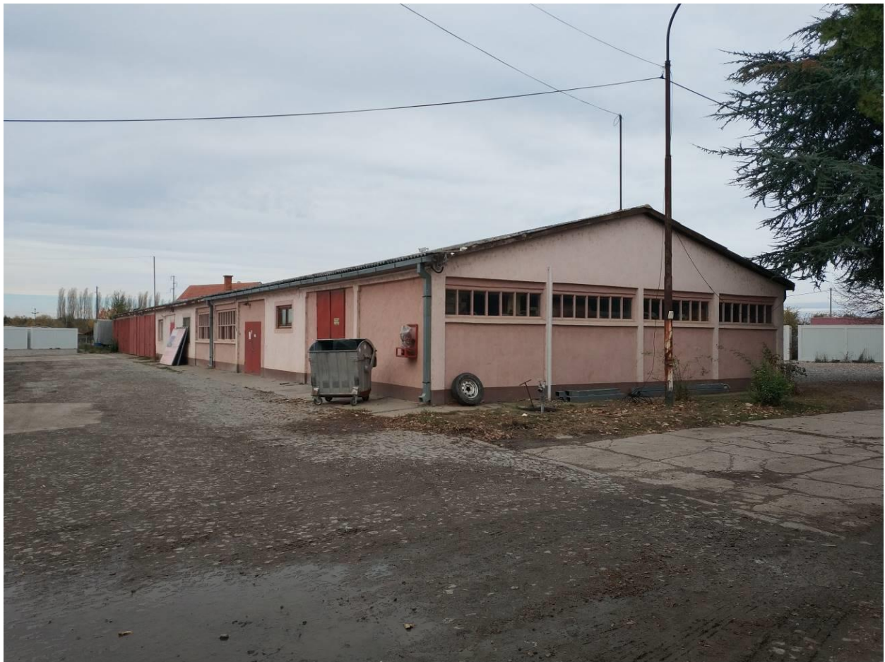
Slika 9. Postojeće skladište koje je potrebno srušiti (demonirati)
