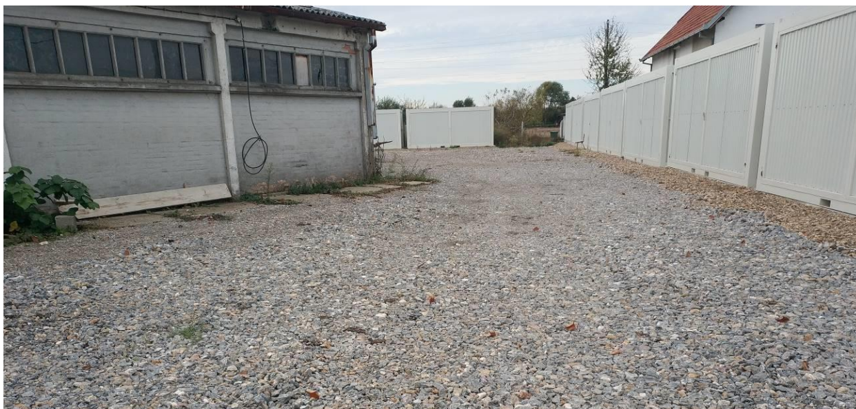
Slika 5. Postojeće skladište predloženo za rušenje/demontažu, kontejneri za skladištenje i stambeni objekat koji se graniči sa katastarskom parcelom
