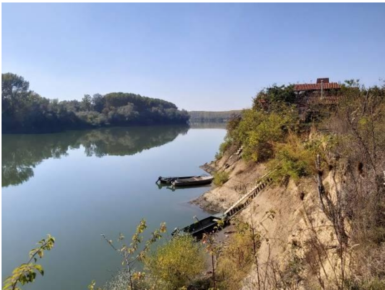
Slika 5. Stambena kuća i najznačajnija oštećenja rečne obale duž deonice koja je predmet projekta
